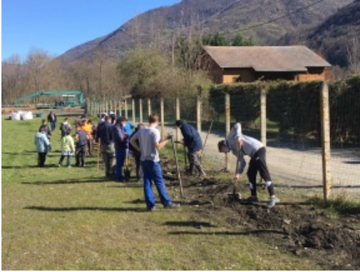
Janvier : le beau temps est présent, les manches sont relevées, si tout est préparé le chantier se passera au mieux !
