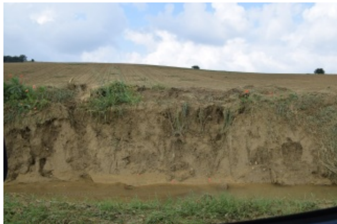
Erosion : Coulée de boue, juin 2017
