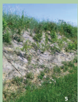
1. Branches de saules pour tresser entre les pieux. 2. Plantations sur un talus reprofilé avec une terrasse. 3. Fascinage sur un talus trop en pente. 4. Mise en place des pieux pour le fascinage. 5. Plantations sur géotextile.
